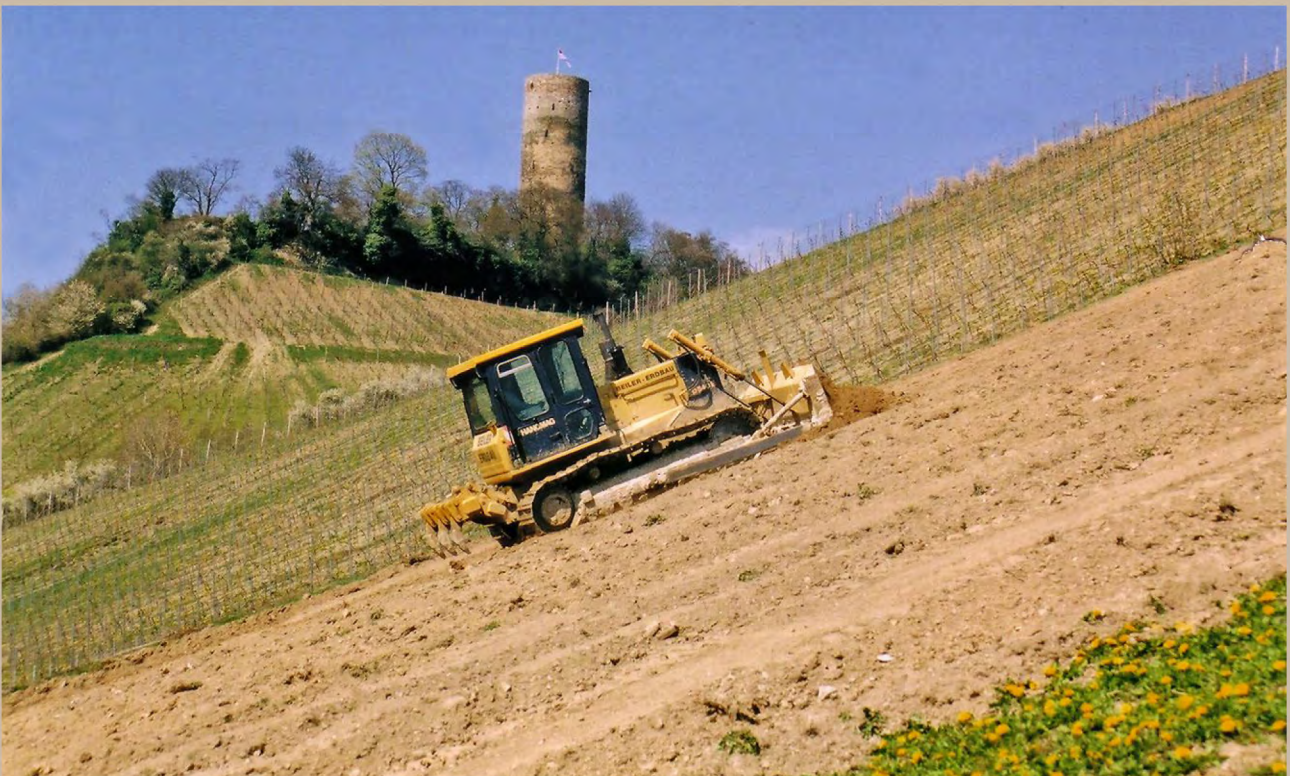
Planierarbeiten nach Errosionsschäden in Kiedrich >Gräfenberg<
