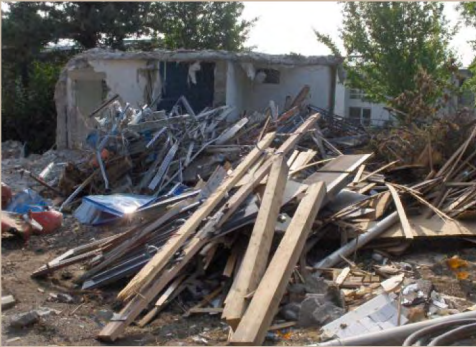
Trennung von Abbruchmaterial
