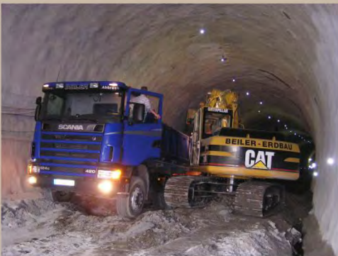
2005 Tiefbauarbeiten und Felsabbruch Loreley- und Roßsteintunnel
