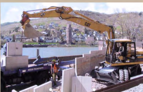
Versetzen von Winkelstützelementen
